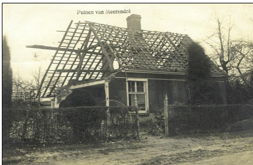
Een van de vele woningen die tot puin werden herleid in Merendree. (Verzameling Carlos Lips)
